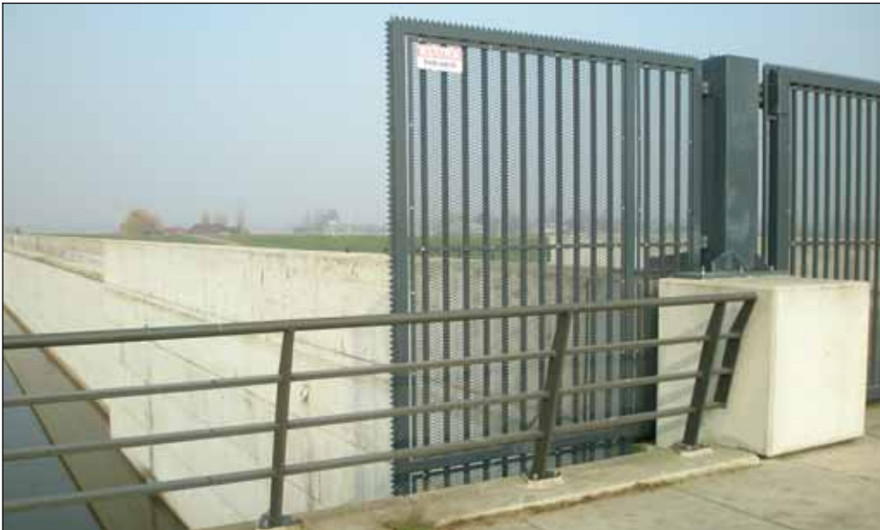
Afbeelding 3: via het betonblok zijn de jongens over het hekwerk geklommen.
