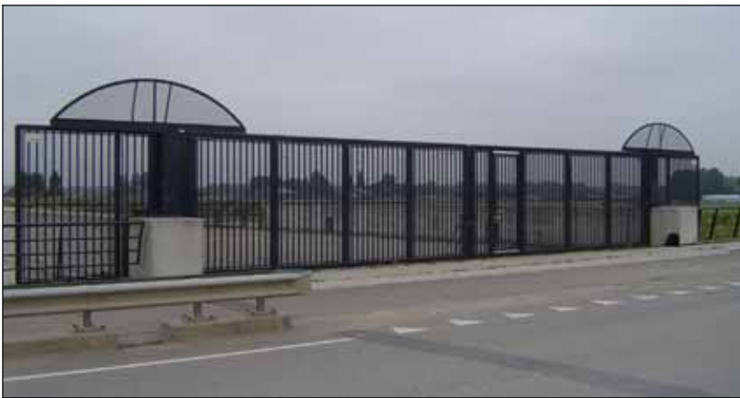
Afbeelding 6: het ter plaatse van de betonnen blokken verhoogde hekwerk op het viaduct "Geerweg"
