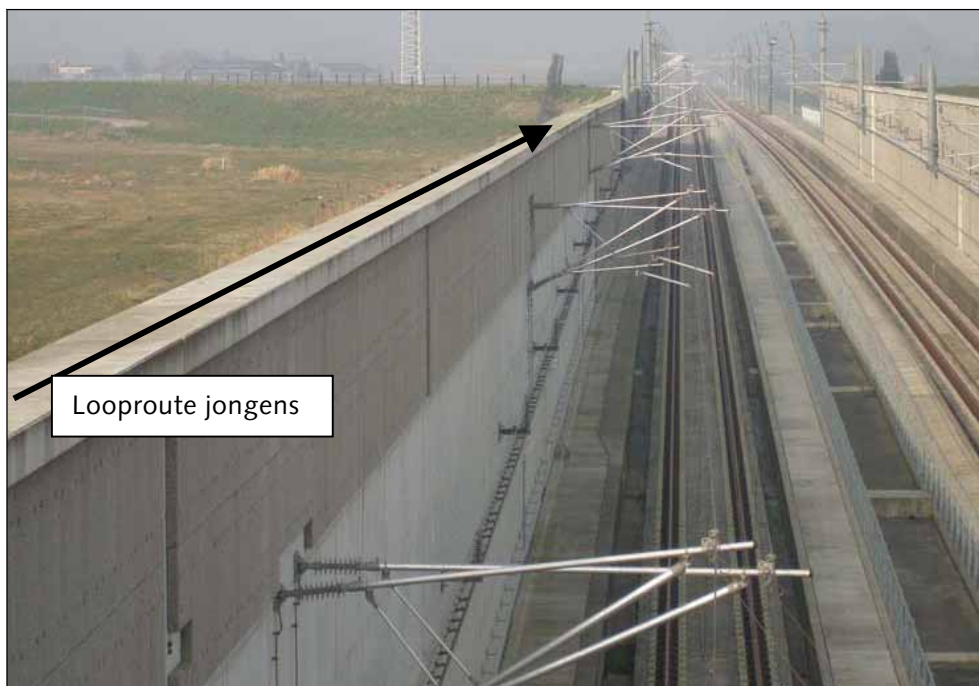
Afbeelding 6: de jongens lopen 150 m over de wand van de verdiepte tunnelbak.
